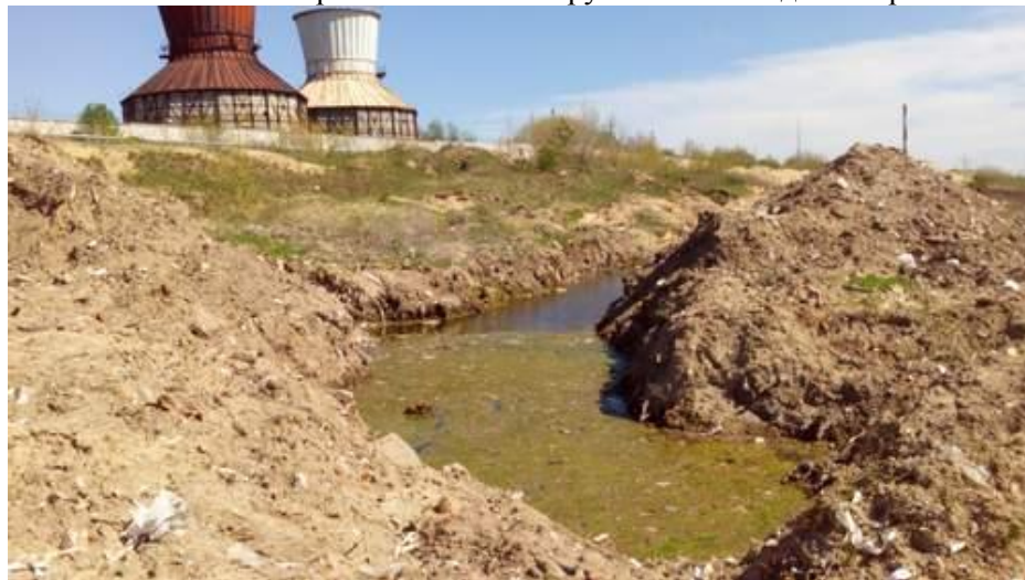
Рис 7 Отстойники старых очистных сооружений на заводе «Капролактам»
