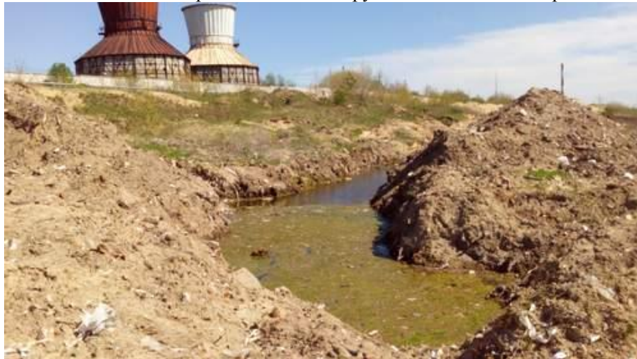
Рис 7 Отстойники старых очистных сооружений на заводе «Капролактам»
