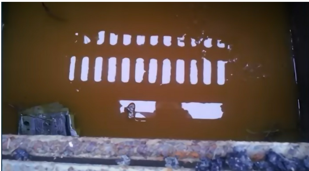
도장 공정 폐수 처리 시설에서 누출된 폐수가 우수관을 오염시킨 모습
