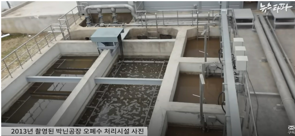
사진 3. 삼성전자 박닌 공장의 오수 처리 시설은 산업 폐수를 처리하도록 설계된 것이 아니었다. 따라서 삼성은 폐수 처리 시설이 건설될 때까지 수년 간 독성 폐수를 환경에 그대로 버렸다.
