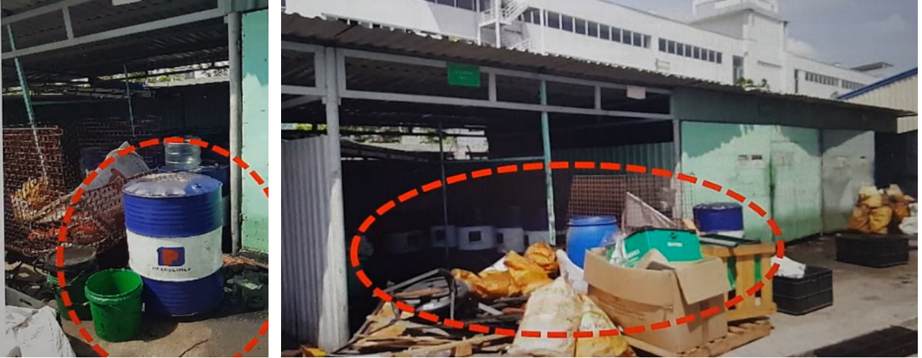
한 삼성전자 협력업체의 유류 저장고에 유출 방지 시설이 설치되어 있지 않아 환경으로 누출되고 있다.
