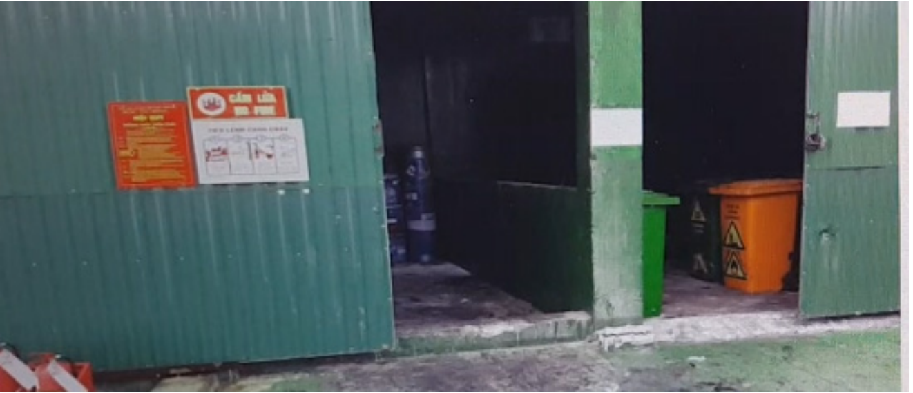
유해물질 누출을 방지하는 배수로나 누유방지턱을 만들지 않은 삼성전자 협력업체의 모습. 흘러나온 오염물질이 옥외로 확산될 수 있다.
