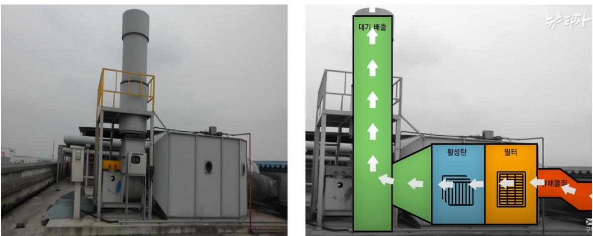
사진 1. 삼성전자 박닌 공장의 대기 오염 방지 시설(왼쪽)과 그 구성 요소를 보여주는 그래픽(오른쪽).
