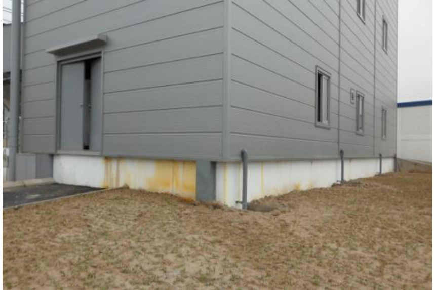
수산화나트륨이나 황산알루미늄 등의 폐수 처리용 화학물질이 폐수 처리 시설 탱크에서 누출되어 방지턱을 넘어 시설 외부로 흘러나온 모습
