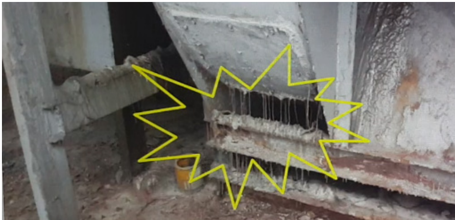
활성탄을 주기적으로 교체하지 않았음을 보여주는 한 삼성전자 협력업체의 활성탄 흡착탑 모습.
