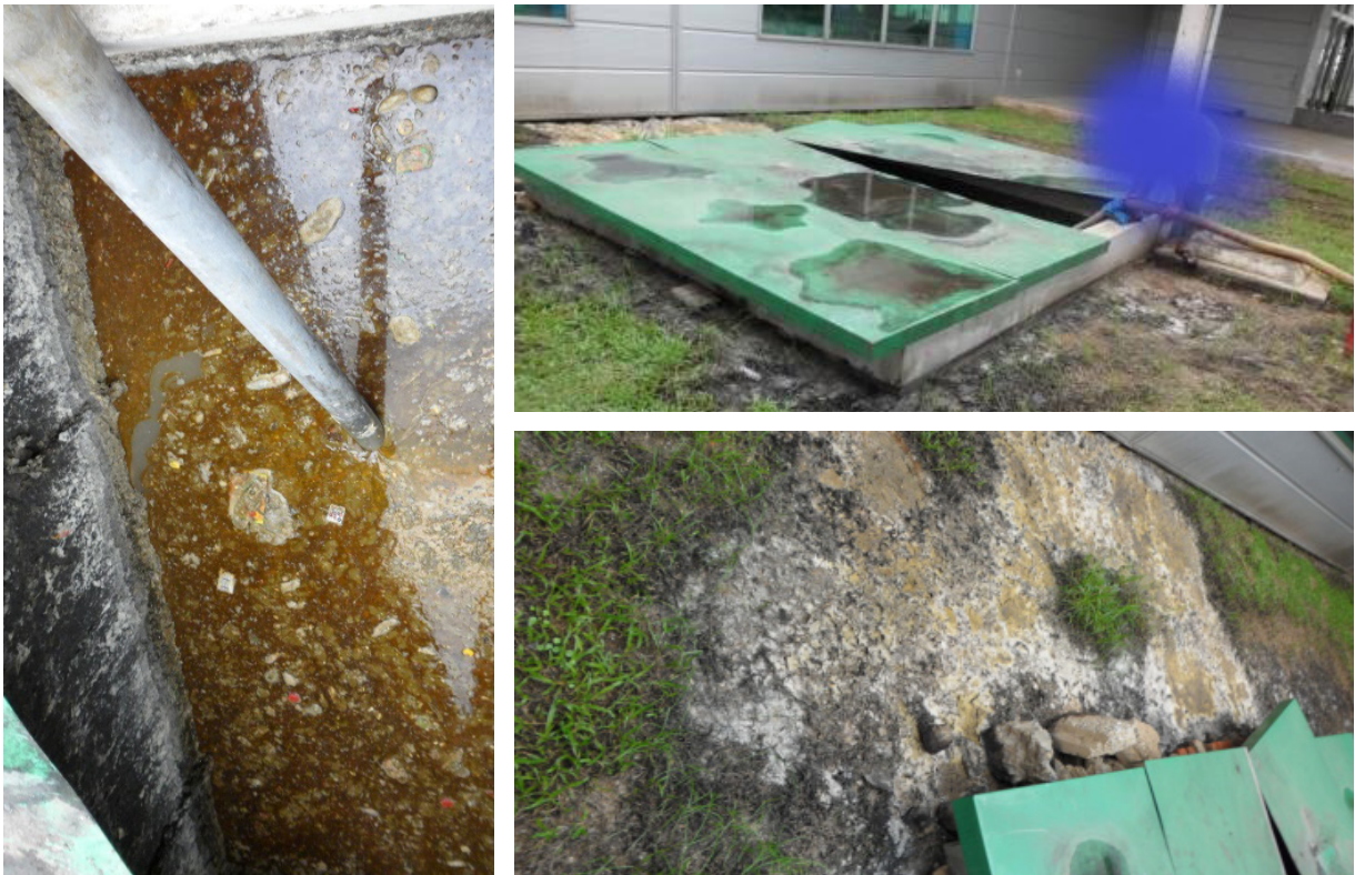
삼성 박닌 공장에서 오수가 탱크 꼭대기까지 차올라서(왼쪽) 탱크 밖으로 흘러넘쳐(오른쪽 위) 주변 토양을 오염시키고 있다(오른쪽 아래).
