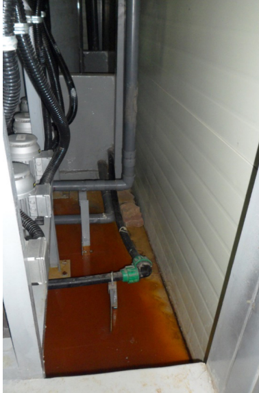
수산화나트륨이나 황산알루미늄 등의 폐수 처리용 화학물질이 폐수 처리 시설 탱크에서 누출되어 방지턱을 넘어 시설 외부로 흘러나온 모습
